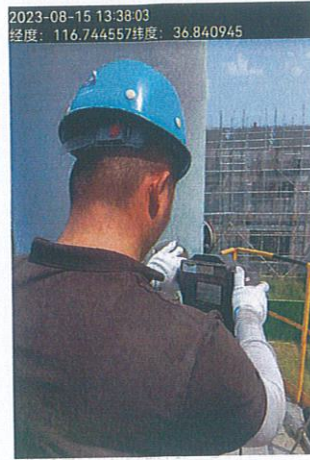
RTO 装置排气筒 (DA059)
