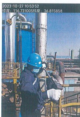
炭黑 3#再处理袋滤器排气筒 (DA024)
