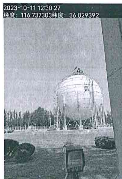
无组织 (液氮罐区)
